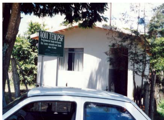
FIGURA 9 - PSF Zona Rural, Município Campo Belo
