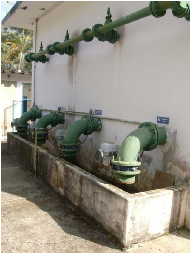
Figura 4: Encanamento (2) ETA Itobí-SP Tirada em visita em 08/06/2010 Autor: José Edel Damasceno Júnior
