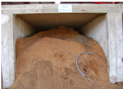
FIGURA 14 – Baia de material seco.
