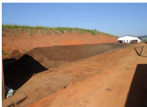
FIGURA 16 – Leira montada em área externa.
