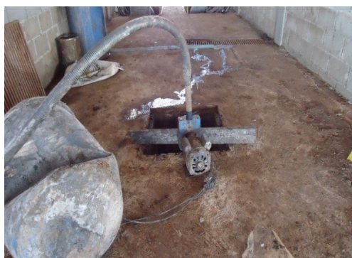
FIGURA 17 – Bombeamento do chorume da caixa de contenção.
